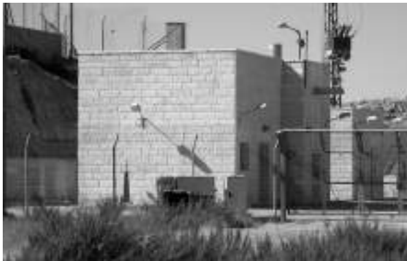
ワディ・フーキン村の上に設置された入植地の汚水処理場。
