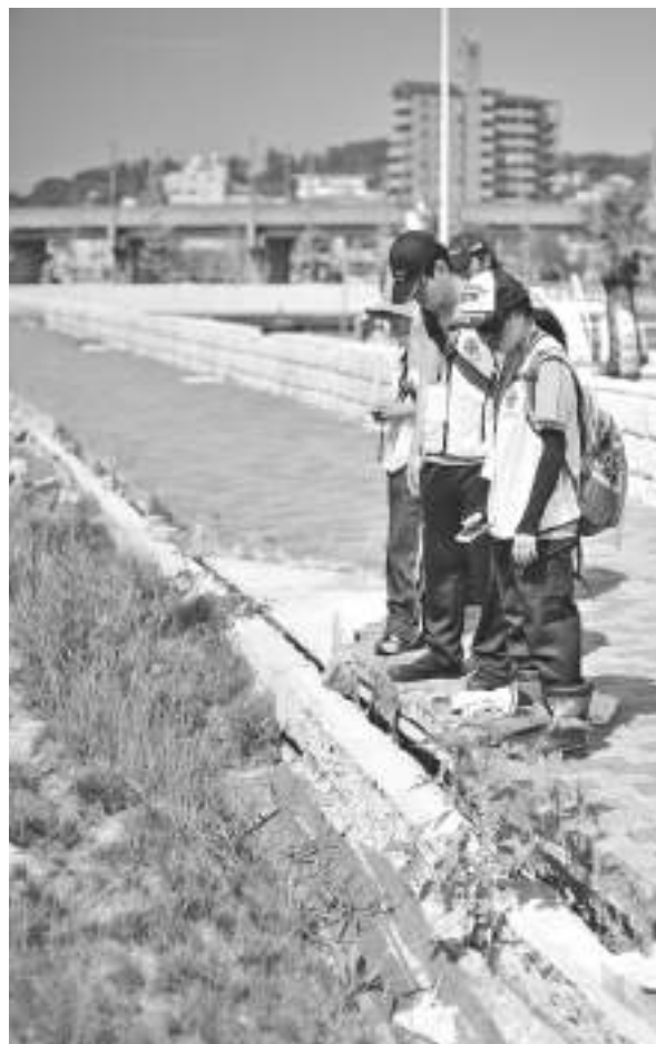
歩道のひび割れに言葉を失う（塩釜市内）。
