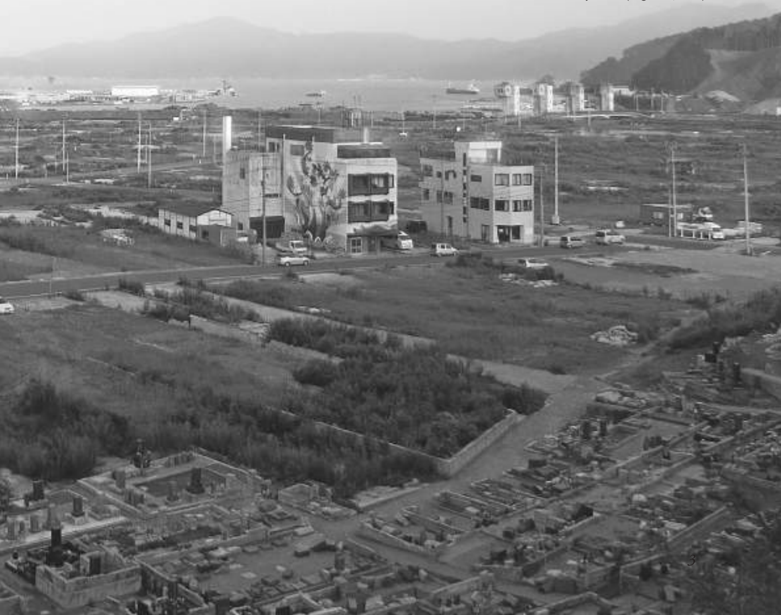
写真 大槌町全景 (2013年8月11日) PHOTO View of Otsuchi town from Shiroyama hill (August 11, 2013)
