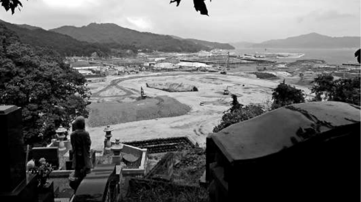
城山公園から望む、大槌町の“元” 中心部。今は宅地造成のために嵩上げ工事が行われている。遠くに見えるのは美しい大槌湾。 A view of the "former" central area of Otsuchi-cho, seen from Shiroyama Park. Under construction to raise the level of the land. Beautiful Otsuchi Bay in the background.
