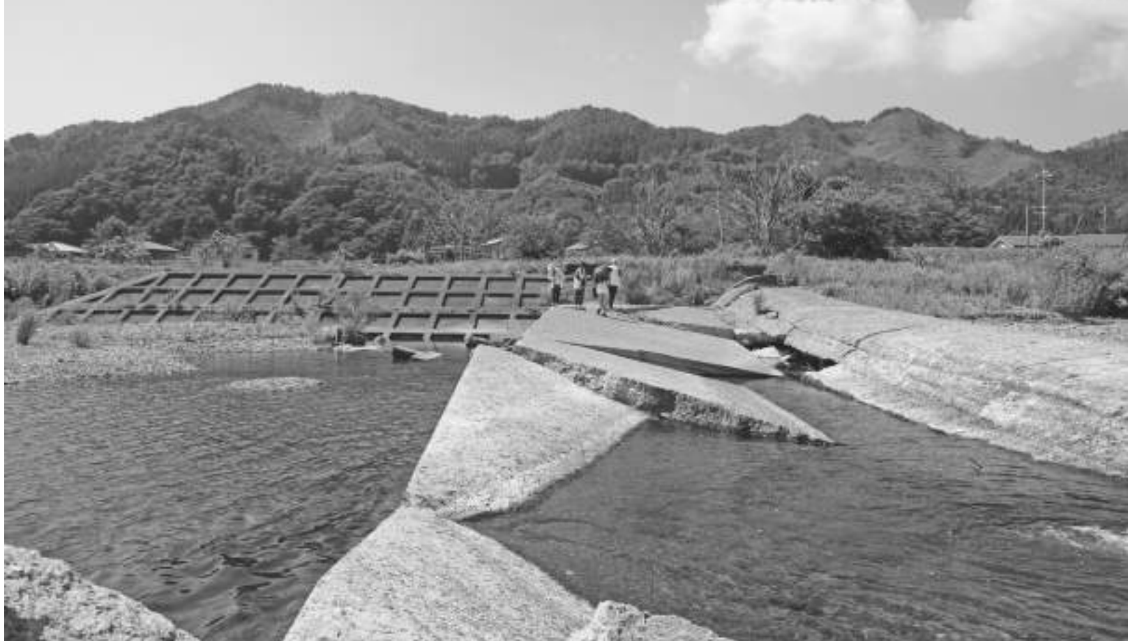
津波の威力で破壊された、大鰐川の堰 The bank of the Otsuchi River broken by the tsunami.
